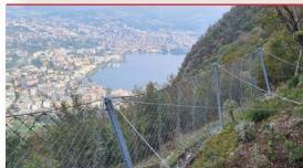
Per proteggere la linea della funicolare e del quartiere di Lugano-Pazzallo a **novembre 2022** sono terminate le opere di premunizione contro il pericolo da caduta sassi tramite la posa di paramassi sulla seconda sezione della funicolare, con un investimento di quasi un milione di franchi.
