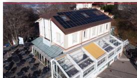
A **metà dicembre 2023** sono terminati i lavori di ristrutturazione del Ristorante Vetta. Le facciate sono state ridipinte, le grondaie sostituite, il tetto risanato e su di esso è stato installato un impianto fotovoltaico per fornire un contributo alla produzione di energia elettrica verde al ristorante.
