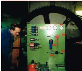
Pendant l'hiver **1982-1983**, des travaux importants, aussi financièrement, sont réalisés. Le personnel du funiculaire effectue des travaux de consolidation le long de la ligne (traverses et murs de soutènement), tandis que les entreprises Kündig et Garaventa remplacent les dispositifs de commande et de réglage de l'installation électrique de traction par une nouvelle installation électrique moderne. La commande de frein mécanique est remplacée par une commande de frein hydraulique.
