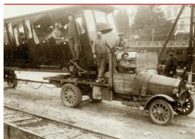
Au cours de l'hiver **1925/26**, l'installation de traction est complètement transformée. L'installation d'une nouvelle machinerie entraîne un accroissement de la vitesse qui atteint désormais 1,8 m/s. La durée du trajet passe ainsi de 26 à 18 minutes. Les vieilles voitures pouvant accueillir 32 voyageurs sont remplacées par deux nouvelles d'une capacité de 65 personnes.
