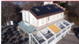
**Mitte Dezember 2023** wurde die Renovierung des Restaurants Vetta abgeschlossen. Die Fassade wurde neu gestrichen, die Dachrinnen wurden ersetzt und das Dach saniert. Zudem wurde eine Photovoltaikanlage installiert, um Ökostrom für das Restaurant zu erzeugen.
