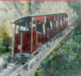
Im Jahr **1938** lieferten die Firmen Bell & Cie. Kriens, die Maschinenfabrik Oerlikon und die Kabelwerke Brugg Traktionsmaschinen, die eine grössere Betriebssicherheit garantierten, jedoch die Auswechslung des Zugseils, des Triebrads, der Traktionsräder, der Riemenscheiben der Bremse und der zugehörigen Apparaturen notwendig machten. Dank diesen Änderungen wurde die Zuggeschwindigkeit von 1,8 Metern pro Sekunde auf 2,5 Meter pro Sekunde erhöht, was die Fahrtdauer auf 14 Minuten verkürzte.
