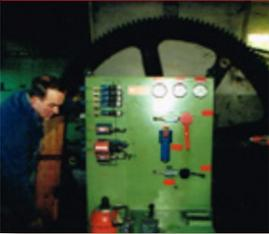
Im Winter **1982/1983** wurden umfangreiche, auch finanziell aufwendige Arbeiten durchgeführt. Das Personal der Standseilbahn führte Konsolidierungsarbeiten entlang der Strecke durch (Schwellen und Stützmauern), während die Firmen Kündig und Garaventa die Kommandoanlagen und die Steuerung der elektrischen Traktionsanlage durch eine moderne elektronische Anlage ersetzen. Die mechanische Bremssteuerung wurde neu durch eine hydraulische ersetzt.
