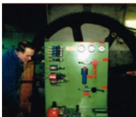
Durante l'inverno **1982-1983** vennero eseguiti lavori di notevole impegno, anche finanziario. Il personale della funicolare eseguì opere di consolidamento lungo la linea (traverse e muri di sostegno), mentre le ditte Kündig e Garaventa provvidero alla sostituzione dei dispositivi di comando e di regolazione dell'impianto elettrico di trazione con un nuovo moderno impianto elettronico. Il comando freni meccanico venne sostituito con un nuovo comando freni idraulico.
