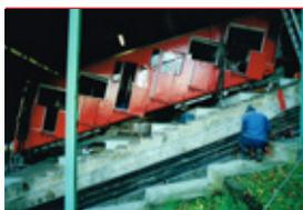
Durante l'inverno **1978-79** il personale della funicolare eseguì una serie di lavori di riattazione e miglioria. L'interno delle vetture venne rifatto completamente con materiale sintetico (formica) e la parte di legno fu riverniciata. La stazione di partenza di Paradiso fu abbellita nello stile "châlet".
