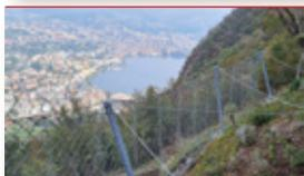
Per proteggere la linea della funicolare e del quartiere di Lugano-Pazzallo a **novembre 2022** sono terminate le opere di premunizione contro il pericolo da caduta sassi tramite la posa di paramassi sulla seconda sezione della funicolare, con un investimento di quasi un milione di franchi.
