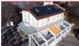
Les travaux de restructuration du Restaurant Vetta se sont achevés **mi-décembre 2023**. Les façades ont été repeintes, les gouttières remplacées, et le toit rénové. En outre, des panneaux photovoltaïques ont été installés sur le toit, afin de contribuer à la production d'énergie électrique verte destinée au restaurant.
