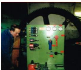
Pendant l'hiver **1982-1983**, des travaux importants, aussi financièrement, sont réalisés. Le personnel du funiculaire effectue des travaux de consolidation le long de la ligne (traverses et murs de soutènement), tandis que les entreprises Kündig et Garaventa remplacent les dispositifs de commande et de réglage de l'installation électrique de traction par une nouvelle installation électronique moderne. La commande de frein mécanique est remplacée par une commande de frein hydraulique.
