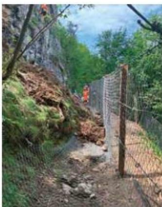
■ Dopo aver rinnovato i due viadotti con una spesa non indifferente di oltre 2 milioni di franchi, opere necessarie per il rinnovo della concessione federale, la Funicolare San Salvatore ha realizzato un'opera di protezione «eccezionale» con reti paramassi alte fino a 4 metri che mettono in sicurezza la sua tratta e anche le zone abitative sottostanti di Pazzallo/Lugano vicino alla stazione intermedia. Per la ditta esecutrice si è
