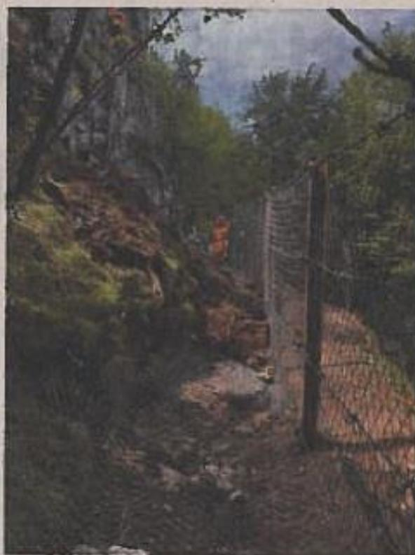
reti, hanno svolto il loro lavoro in piena fiducia e sicurezza. Ci sono voluti diversi voli di elicottero per il trasporto di materiale. In totale sono stati posati circa 300 metri di nuove reti paramassi con altezze variabili da 3 a 4 metri e classi di energia da 500 a 2000 kj.
