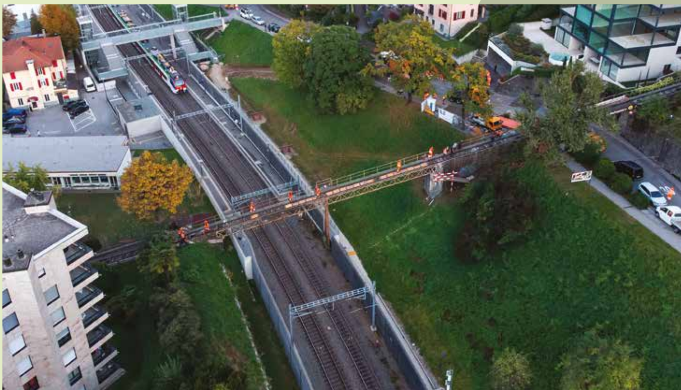
Riposizionamento del ponte a fine novembre 2021
