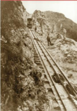
Am **20. Januar 1890** fand der erste Traktionsversuch mit elektrischer Kraft statt, geliefert von den in Maroggia gelegenen Generatoren. Der Versuch zeigte beste Ergebnisse und die Wagons durchliefen die ganze Linie, 1600 Meter, in 26 Minuten.
