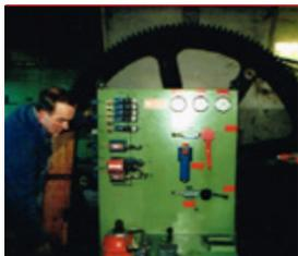
Im Winter **1982/1983** wurden umfangreiche, auch finanziell aufwendige Arbeiten durchgeführt. Das Personal der Standseilbahn führte Konsolidierungsarbeiten entlang der Strecke durch (Schwellen und Stützmauern), während die Firmen Kündig und Garaventa die Kommandoanlagen und die Steuerung der elektrischen Traktionsanlage durch eine moderne elektronische Anlage ersetzten. Die mechanische Bremssteuerung wurde neu durch eine hydraulische ersetzt.
